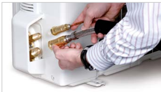
Einfache Montage durch separat erhältliches Anschluss-Set
